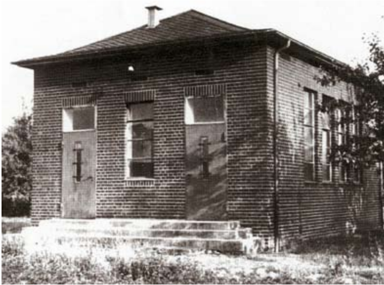
1953 bauen die Stadtwerke eine neue Gas-Übernahmestation in Büscherhöfen
