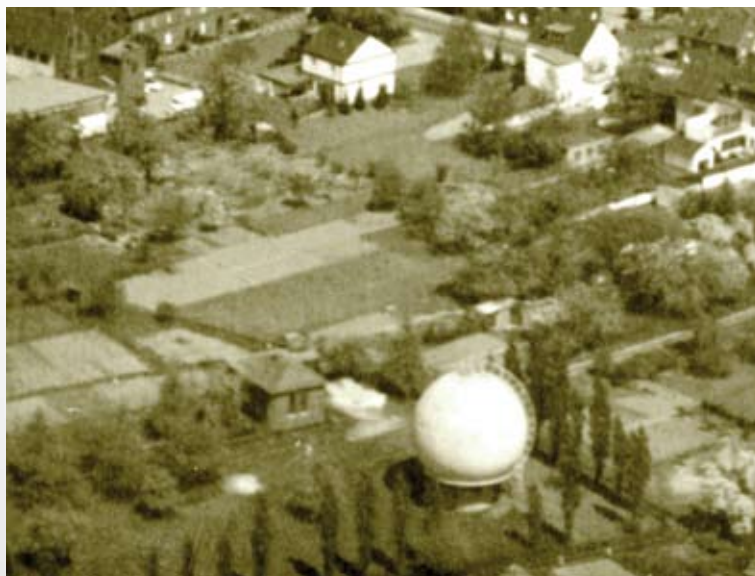
1957 komplettieren die Stadtwerke die neue Gas-Übernahmestation in Büscherhöfen mit einem 8.500 Kubikmeter fassenden Kugelgasbehälter
